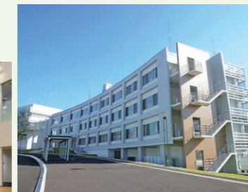
▲カーボンニュートラル・エネルギー国際研究所第2研究棟/外観
